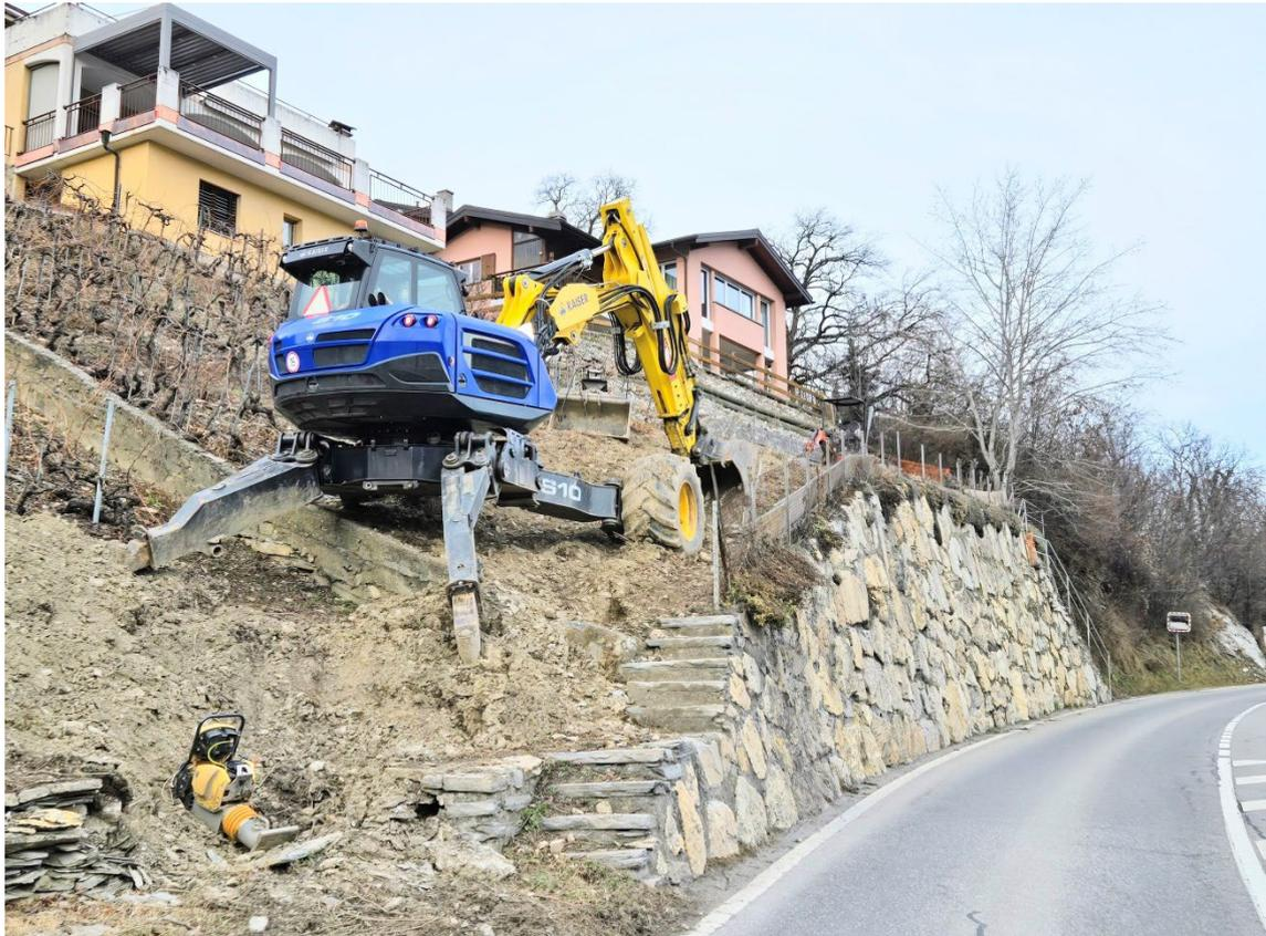
Dans le cadre du chantier, la sécurisation de la paroi rocheuse située juste à l'amont a également été entreprise. Les travaux ont consisté en la purge du rocher et en la pose de treillis métalliques permettant d'assurer la stabilité de secteur.
