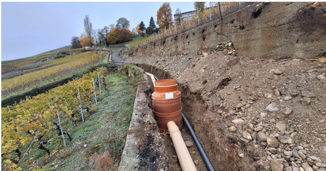
Le projet ainsi réalisé permet ainsi de mettre hors service les deux STEP existantes. Ces dernières, très coûteuses à l'exploitation, ne permettaient plus d'assurer l'épuration suffisante des eaux usées. Le nouveau collecteur posé permet de raccorder les égouts de St-Raphaël et de Molignon à la grande STEP de Châteauneuf. L'investissement permettra à l'avenir une optimisation des coûts d'exploitation tout en assurant un traitement des eaux respectant les exigences légales en vigueur.
