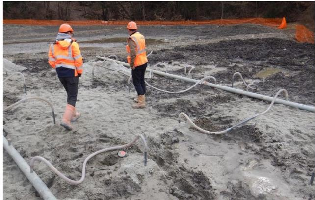
Pour améliorer la gestion des matériaux issus du curage de l'étang de Revouire une technique de séchage par well-points a été mise en place. Ce système est composé d'un réseau de tubes perforés d'une profondeur de 2 à 4 m qui sont insérés dans les dépôts des matériaux humides. Une pompe crée un vide dans ces tubes, aspirant l'eau du sol et permettant d'assécher plus rapidement ces matériaux boueux.
